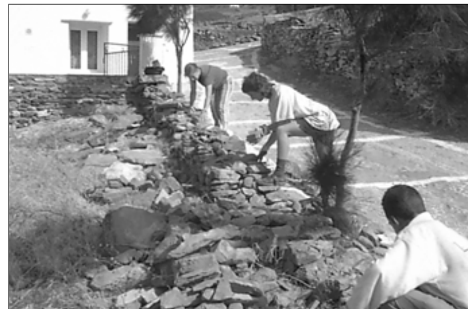
Tinos : chantier de bénévoles
